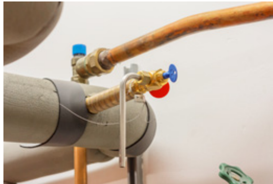
Auch an zentralen Wasserentnahmestellen wird beprobt.
