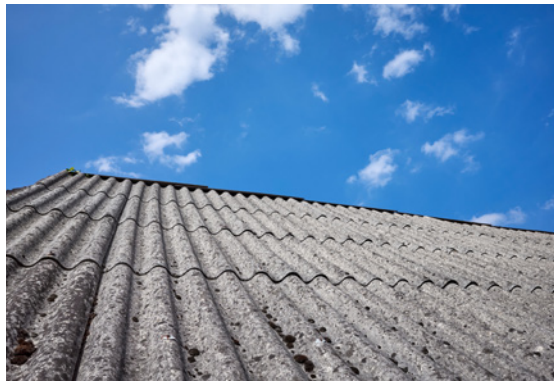
Bis 1989 wurden Faserzementplatten mit Asbest produziert. Und noch heute bedecken sie viele Dächer.
